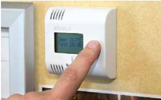
Temperaturgivaren skickar en signal från lägenheten till styrenheten i värmecentralen.
