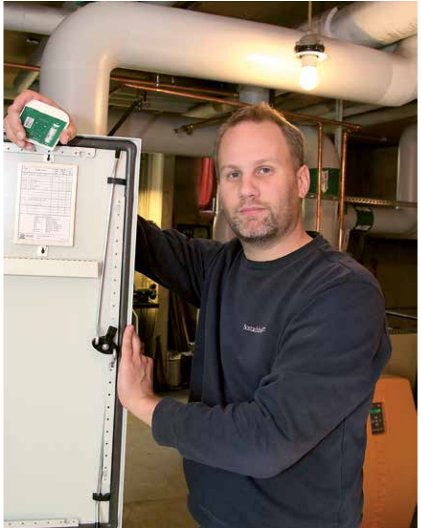
Marcus Nejdell berättar att fjärrvärmecentralen på Tunet är Bostadsbolagets nyaste anläggning. Härifrån levereras värme och varmvatten med senaste teknik.
